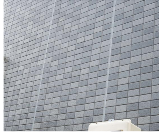
外壁タイル異常無し
